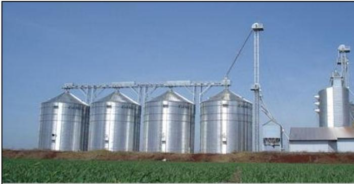
Unidade armazenadora com conjunto de silos metálicos, transportadores e secador de torre
