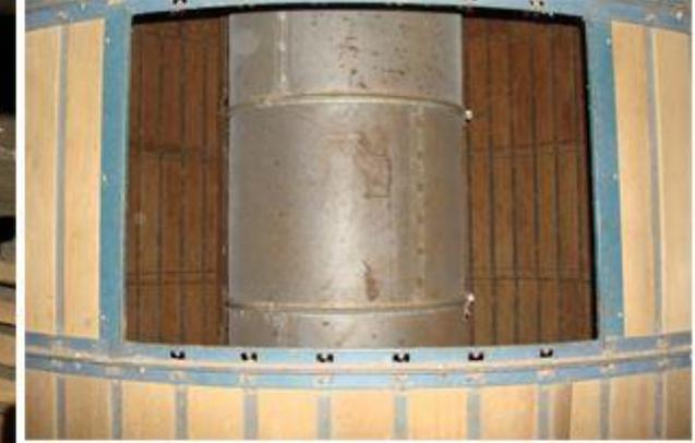
Figura 4. Detalhe dos alvéolos para aeração de silos para armazenamento de sementes.
