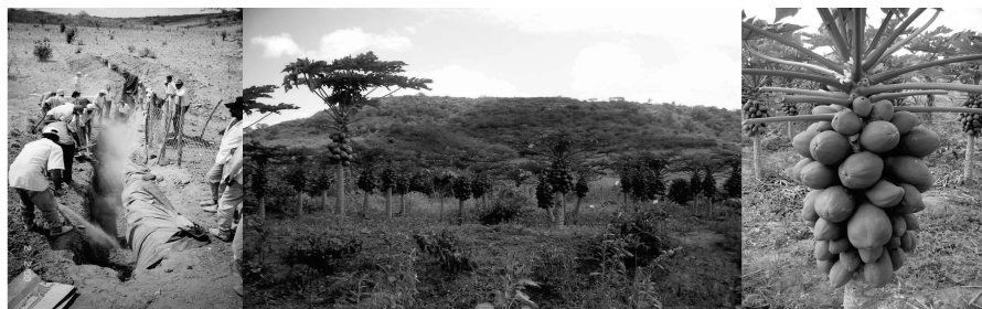
Barragem subterrânea em construção e terminada, produzindo.
