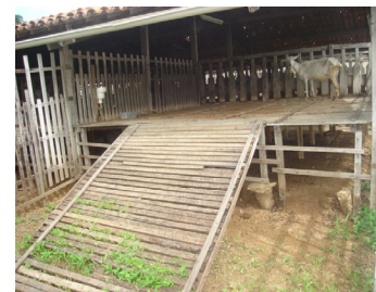
Aprisco suspenso – piso ripado de madeira
