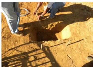
Preparação da forma escavada
