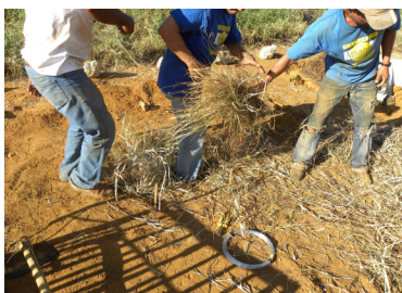
Compactação do material
